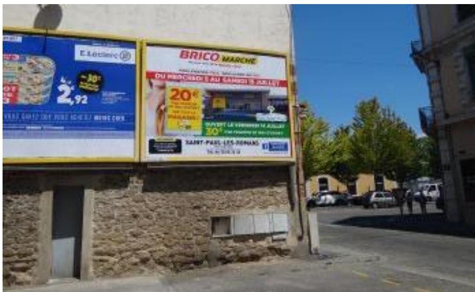
Exemple de dispositifs non conformes (situés dans le SPR) et portant atteinte au territoire
