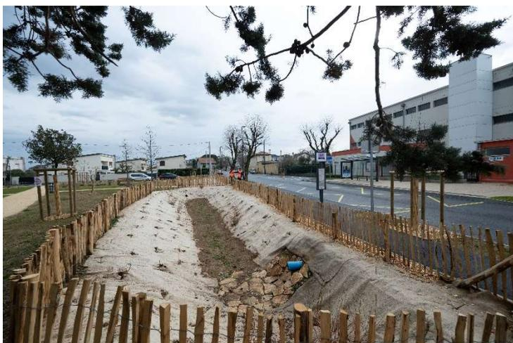
Création d'une noue : sorte de fossé peu profond et large, végétalisé, avec des rives en pente douce, qui recueille provisoirement de l'eau de ruissellement, soit pour l'évacuer vers un trop-plein, soit pour la stocker et la laisser s'évaporer et/ou s'infiltrer sur place, permettant ainsi la reconstitution des nappes phréatiques -
