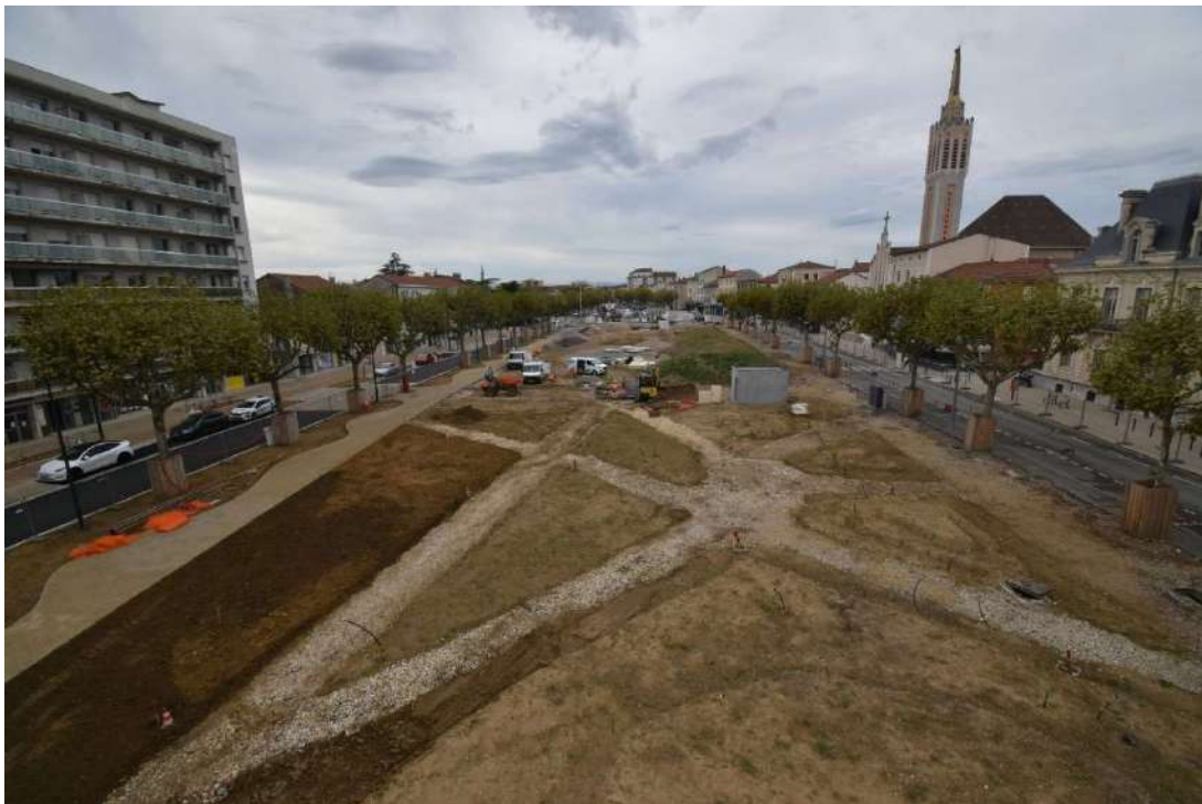
Vue du secteur Est du chantier au 2 octobre
