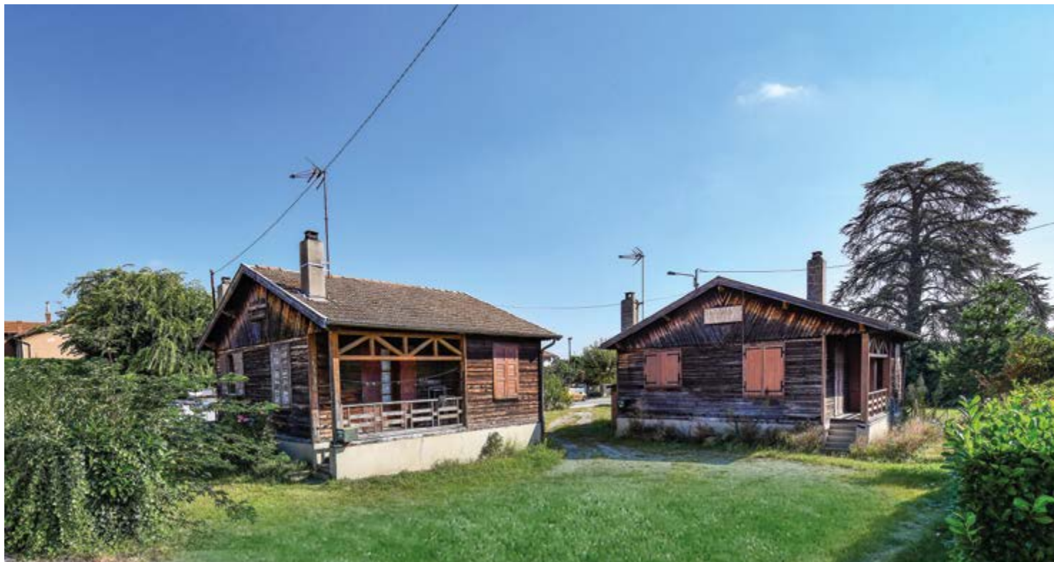
Une nouvelle maison de santé va voir le jour sur l'emplacement des «chalets DOP». Le terrain a été vendu dans le cadre du dispositif Invest'in Romans.
