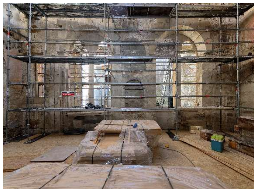
Baies gothiques en cours de restauration, octobre 2023 - Blaise Adilon
