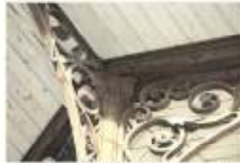
Figure 25 - Charpente métallique de la structure métallique
