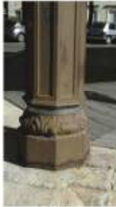
Figure 22 - Base du pilier métallique
