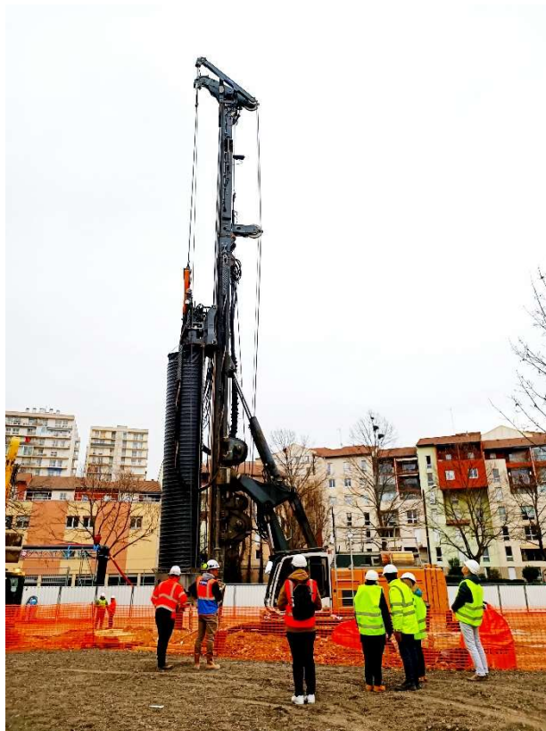
La machine, utilisée par l'entreprise Franki Fondations permet de forer, d'évacuer la terre et de couler le béton
