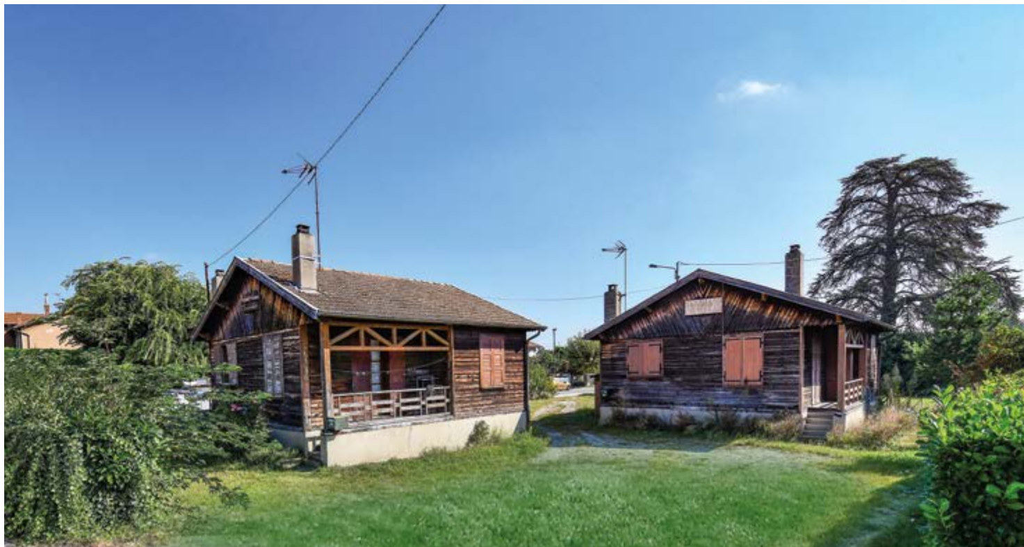
Une nouvelle maison de santé va voir le jour sur l'emplacement des «chalets DOP». Le terrain a été vendu dans le cadre du dispositif Invest'in Romans.
