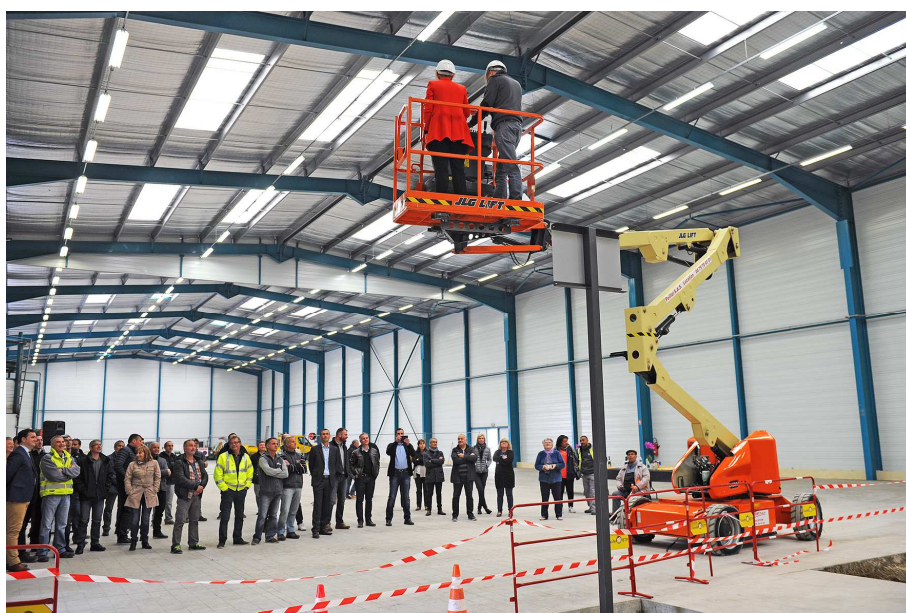
L'entrepôt avant travaux – 1 re pierre – mai 2017 @Joël-Garnier – Ville de Romans-sur-Isère
