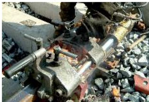
La libération a lieu quelques jours après l'opération de mise à niveau de la voie, et a pour objectif de borner les contraintes internes que supportera le rail du fait des variations de températures. Lors de cette opération, le rail est artificiellement amené à une température comprise entre 20 et 32 °C.
