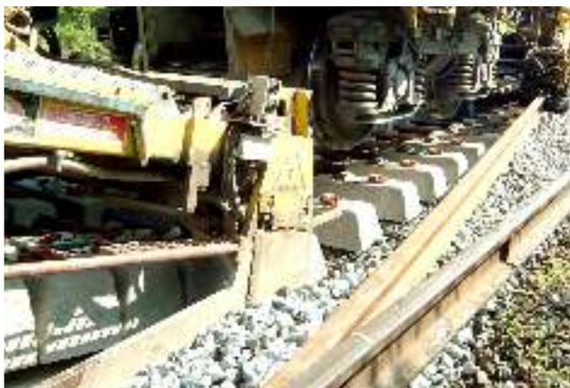
Les anciens rails sont détirefonnés puis écartés de la voie par le train de substitution. Celui-ci enlève ensuite les vieilles traverses et les remplace immédiatement par des traverses monobloc en béton précontraint équipées d'attaches de fixation rail/traverse "FastClip". Les longs rails neufs de 400 mètres, déchargés préalablement sur le côté de la voie, sont progressivement mis en place, fixés sur les traverses puis soudés entre eux par aluminothermie.
